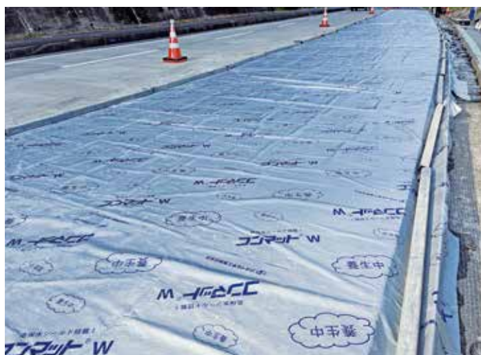
▲コンクリート舗装の湿潤養生
