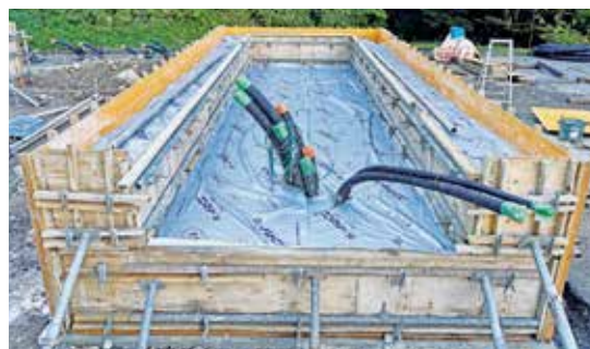
▲コンクリート基礎での保水養生例
