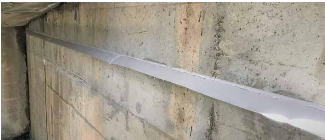
▲構造物側面にウォーターカッター(側面用)の設置状況
