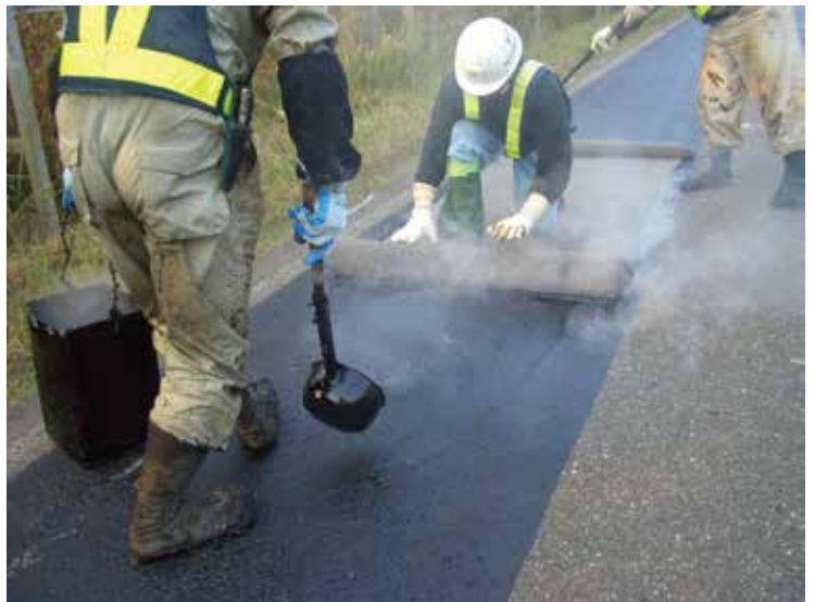
▲クラック上へのジョイントフープN-200(S)貼付状況
