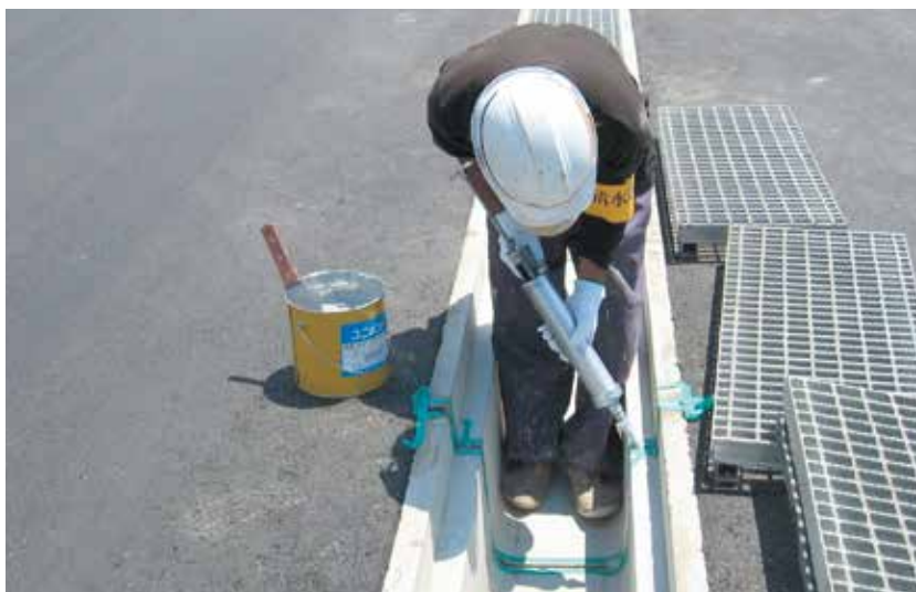
▲U字溝目地にユニボンド3200Nグレー施工状況
