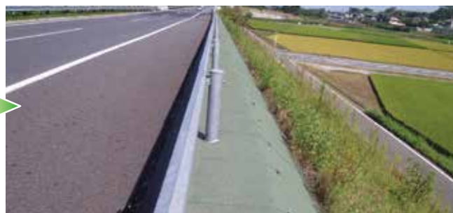
▲施工5年経過状態
