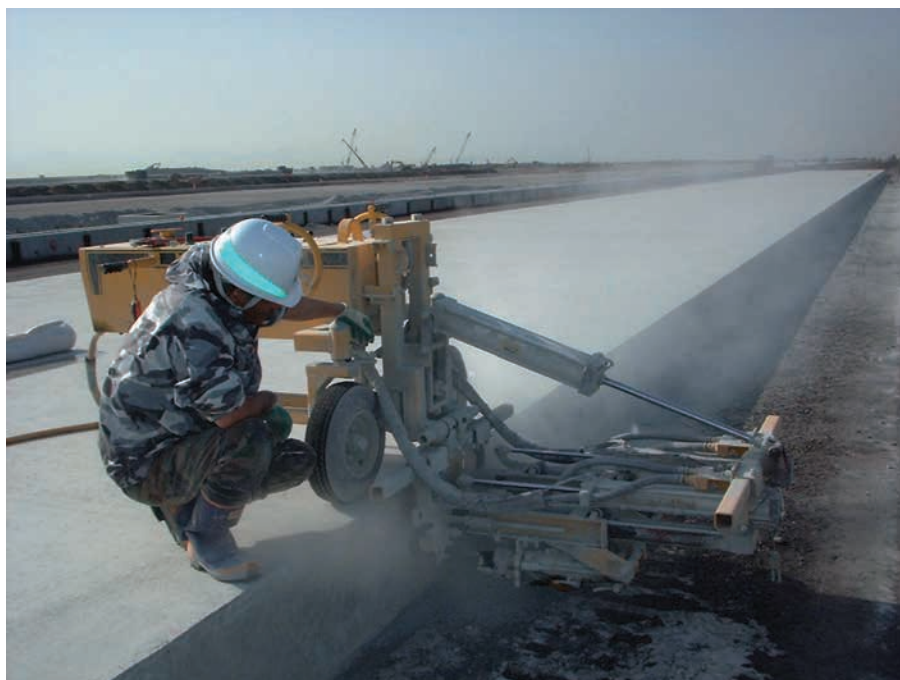
▲EZドリル(210B-2 SRAタイプ)で削孔状況 当社にて施工を請負います。
