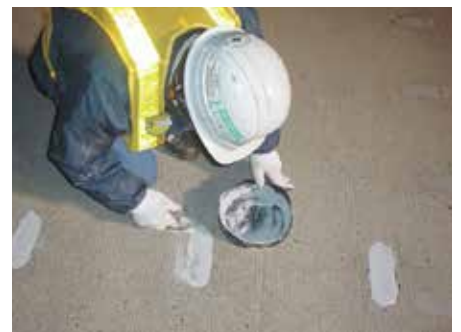
▲ホーンジョイントの跡埋め材として、コールミックスグレーを使用
