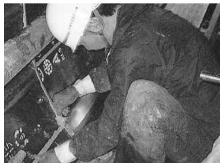
▲シールド工の1次止水にボンドトップWAを使用
