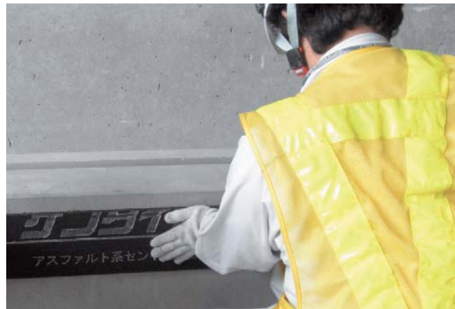
▲ケンタイト貼り付け状況
