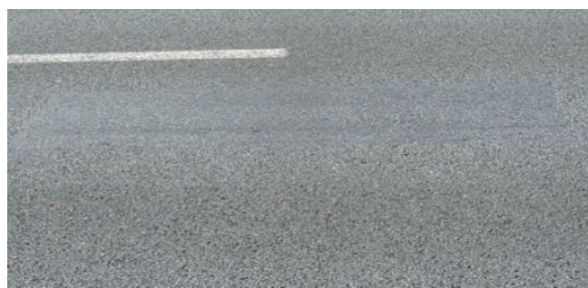
▲施工後約6ヶ月の状況
