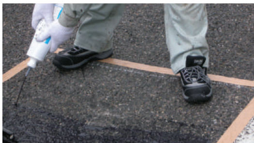
1.主剤と硬化剤を混合し、施工面上へ吐出します
