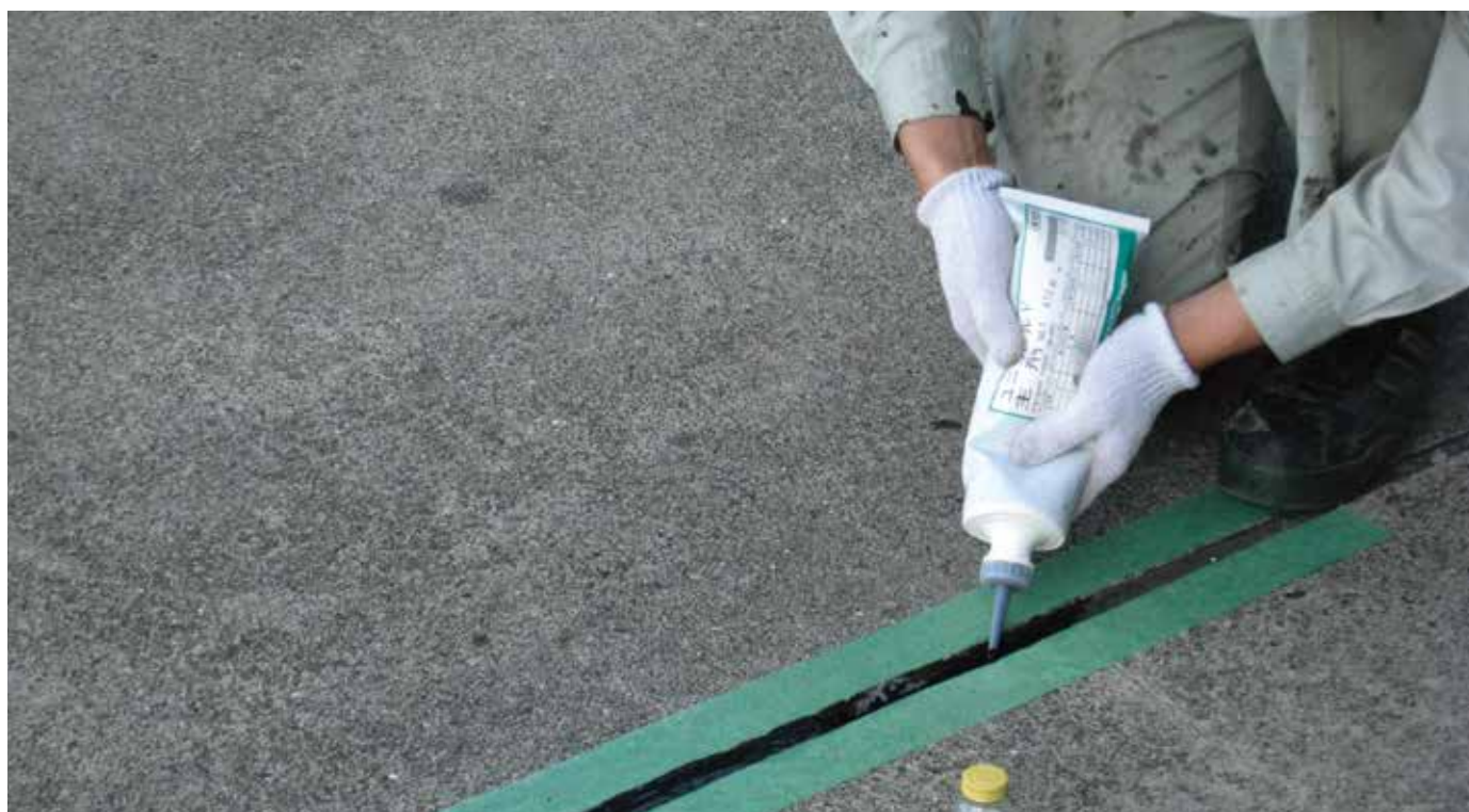
▲コンクリート舗装の水平目地へ注入状況
