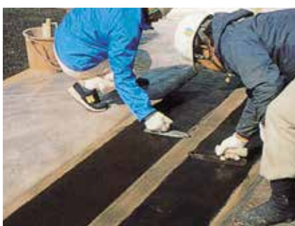
▲表面処理材仕上げ状況
