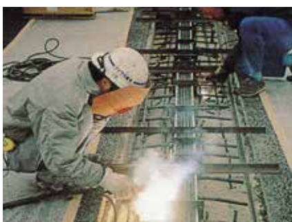
▲配筋溶接状況
