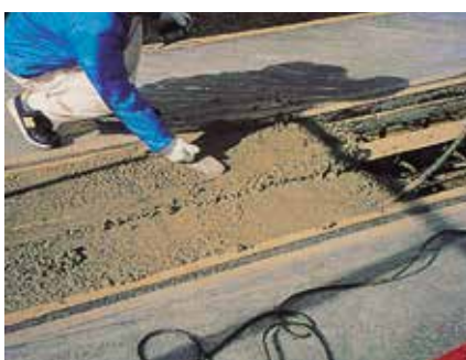
▲コンクリート打設状況
