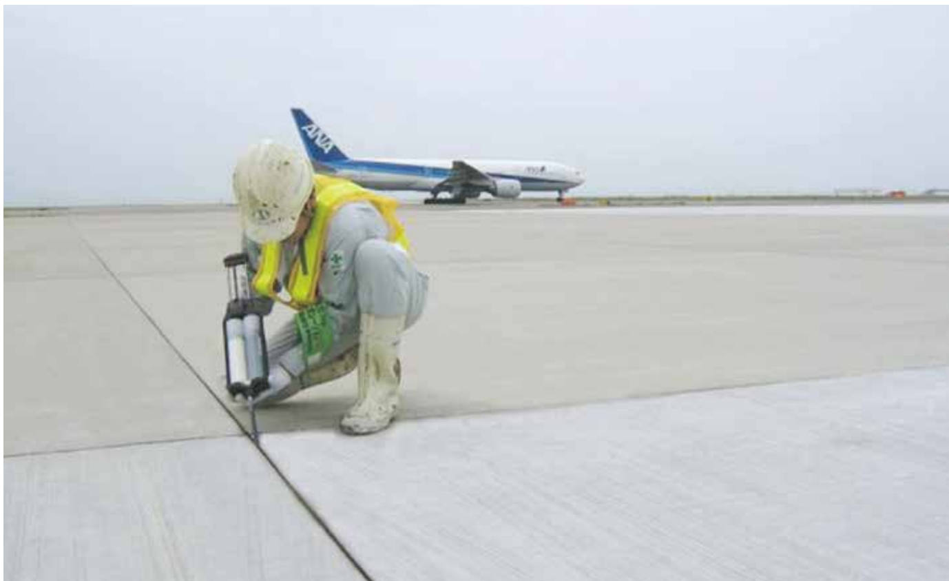
▲中部国際空港エプロン目地注入状況
