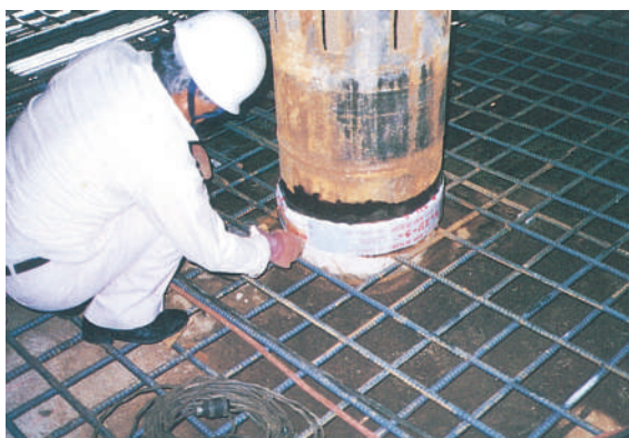
◀土間コンと鉄柱のエキスパンションジョイントに使用
