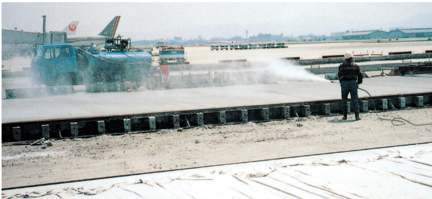
▲駐機場拡幅コンクリート舗装へのハードコート・クイックの散布状況
