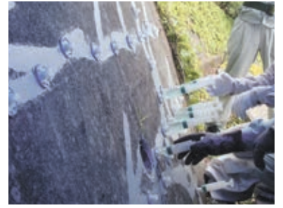
3. 亜硝酸リチウム溶液の先行注入 (追加注入が可能)
