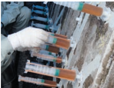
4. リハビリボンドの注入 (追加注入が可能)
