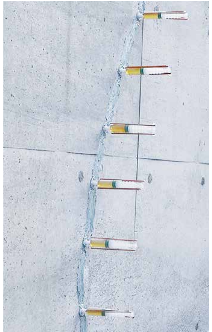
▲CRBインジェクターを用いた注入補修状況
