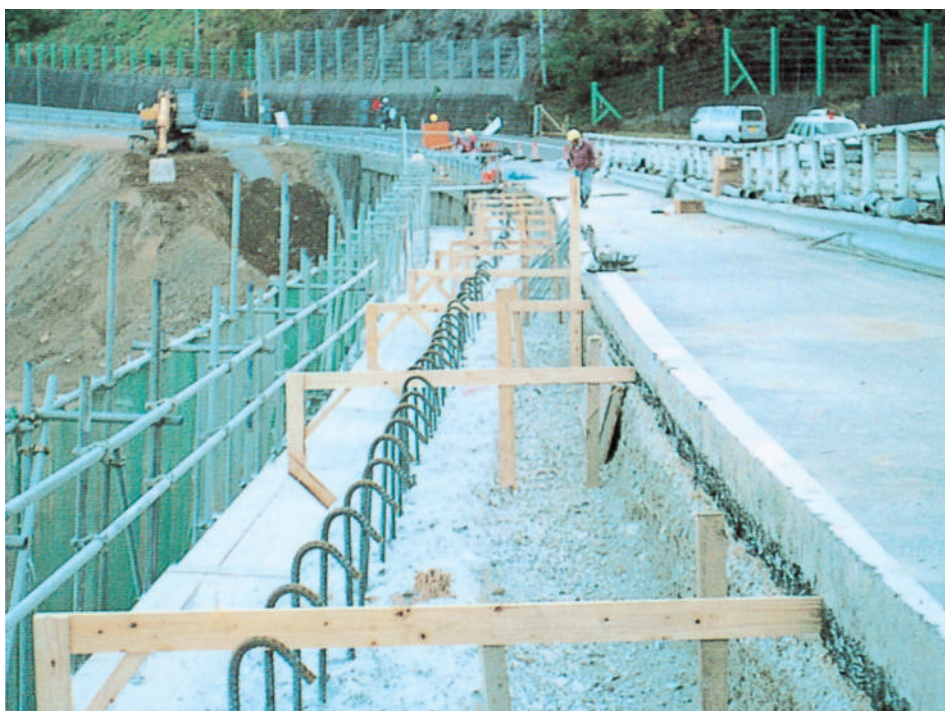
▲コンクリートのかさ上げ
