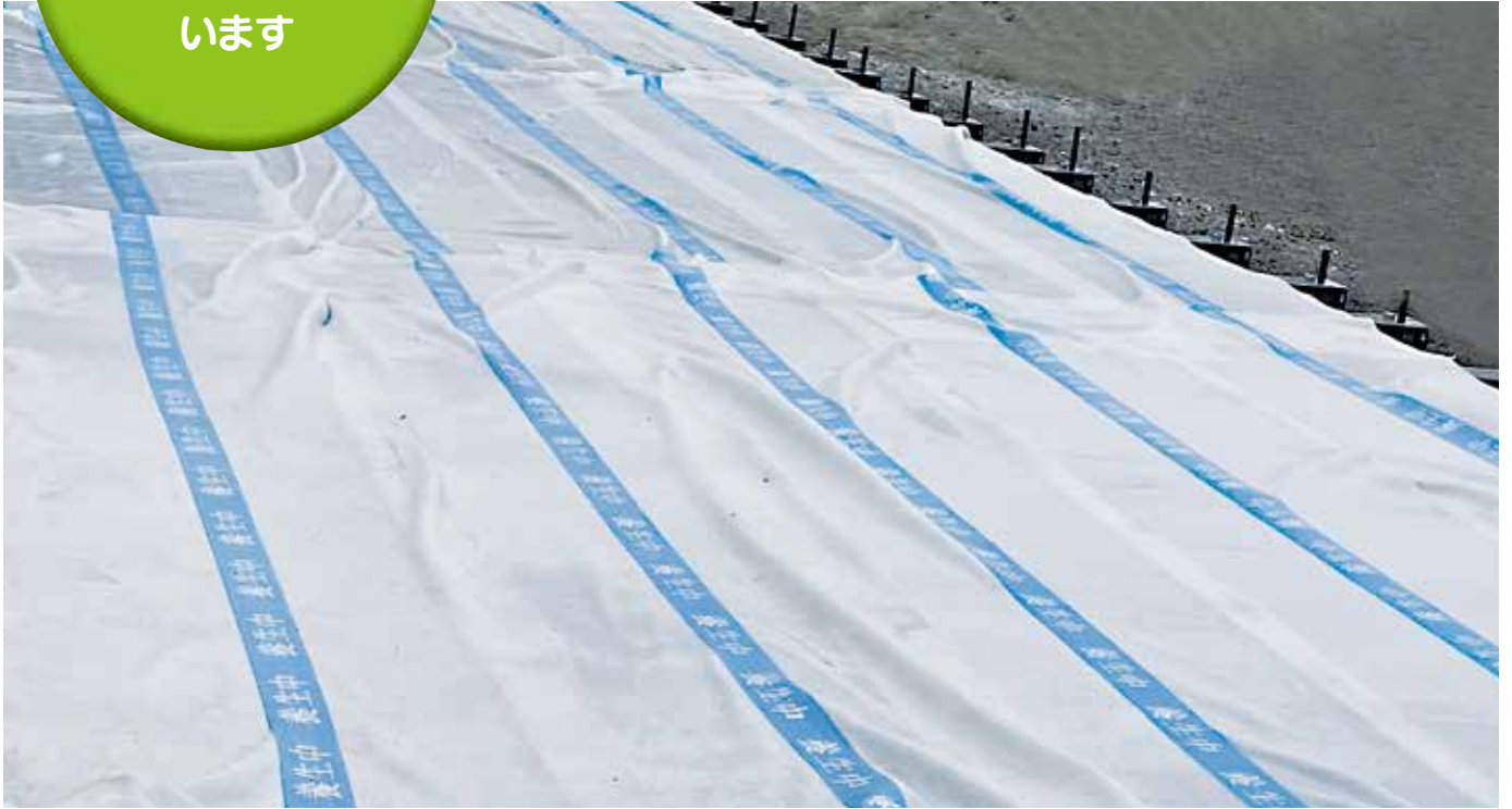
▲コンマツト1号-Aにて養生中現場
