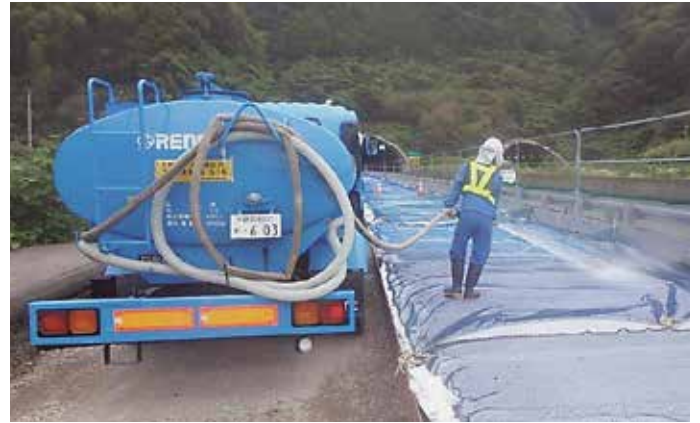
▲マツの上から散水
