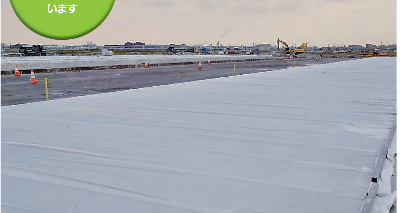
▲コンマツト1号にて養生中現場
