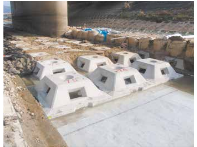
▲根固めブロックの固定にキュアマットINT-10を使用
