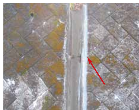
▲目地欠損部の角欠け補修
