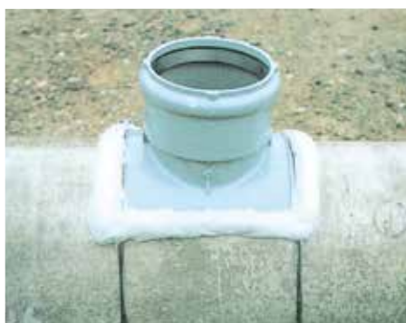
▲ヒューム管と塩ビ支管の固定
