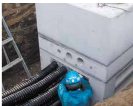
▲ハンドホール横穴と樹脂製配管の固定
