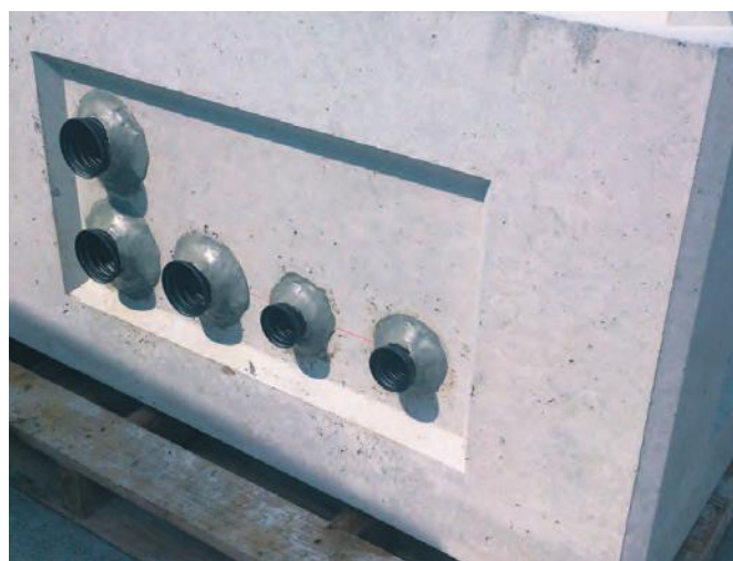
▲樹脂製配管を所定の位置にWKで固定
