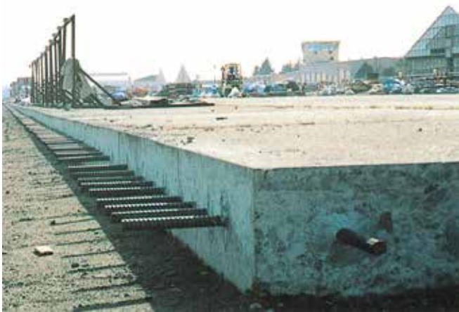
▲アンカーボルト固定にボンドトップWG(A)使用
