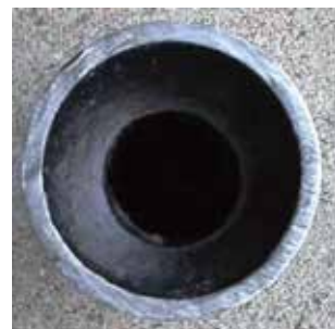
▲専用充填材の充填状況
