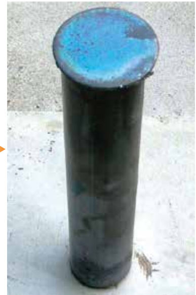
③施工完了。
