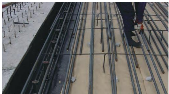
▲踏掛版へAOIベアリングパッドとアンカーバーセットの設置状況
