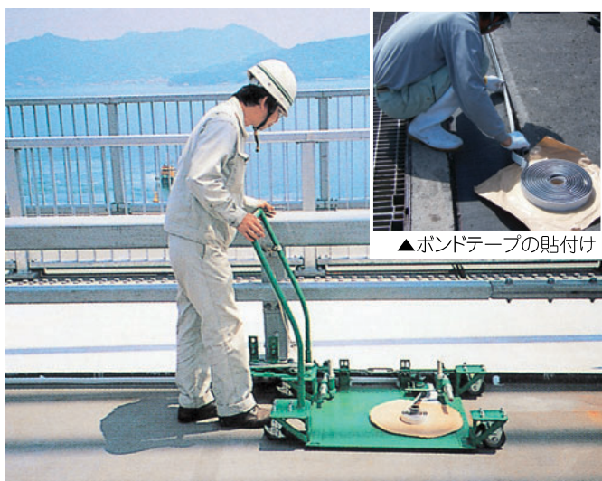
▲貼付け機による施工状況
