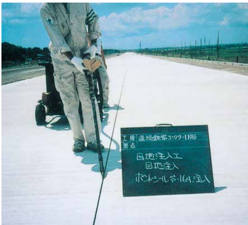
▲ボンドシールS-164にて施工中
