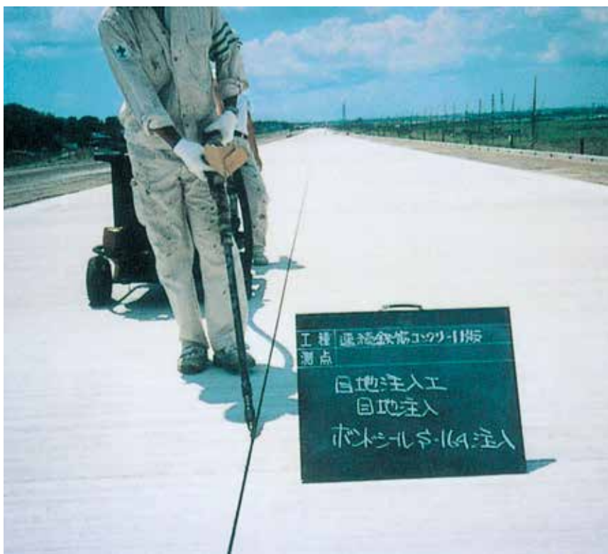
▲ボンドシールS-164にて施工中
