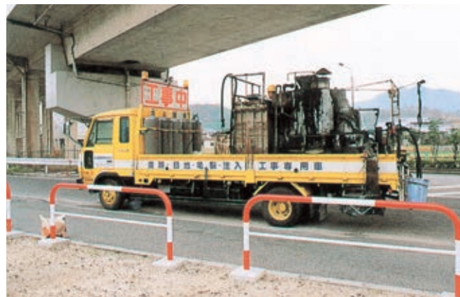
▲工事専用車の一例
