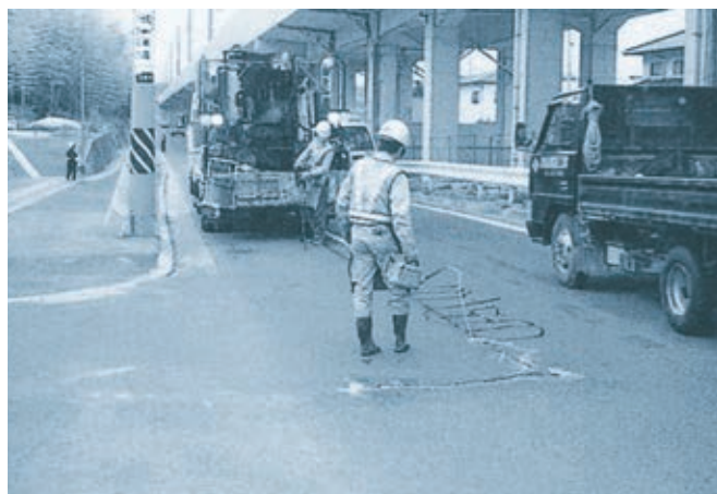
▲仕上げ メンデシールへ石粉水の散布
