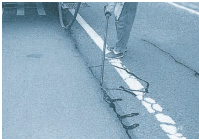
▲メンデシールの注入充填 加熱シール機による注入充填(一例)
