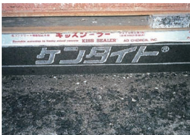
▲コンクリート舗装側目地の目地板(ケンタイト)仮固定に使用
