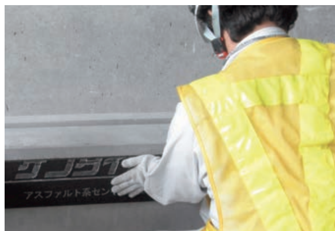
▲ケンタイト貼り付け状況
