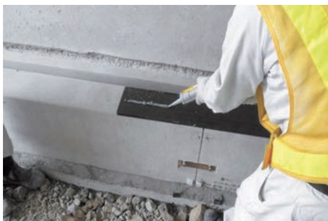
▲ボンドライン塗布状況 (使用量 約20ml/m(口径Φ5mm)) ボンドライン1本で約16m分を使用目安として下さい。
