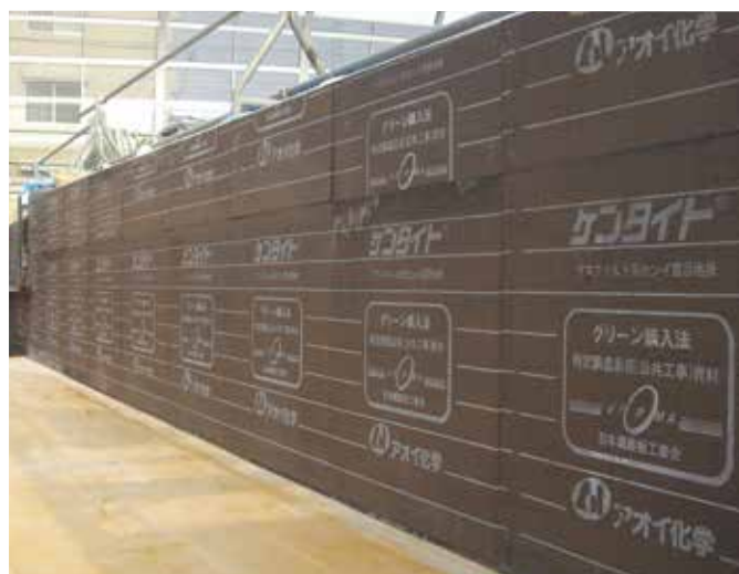
▲現場打ちカルバートの目地に使用
